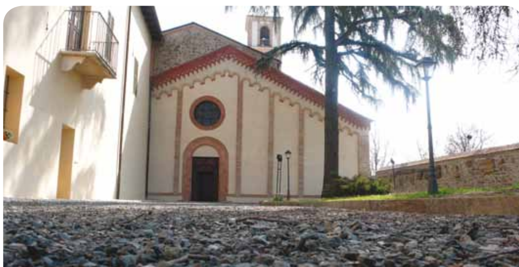
I restauri dell'Abbazia S. Maria della Neve di Torrechiara
